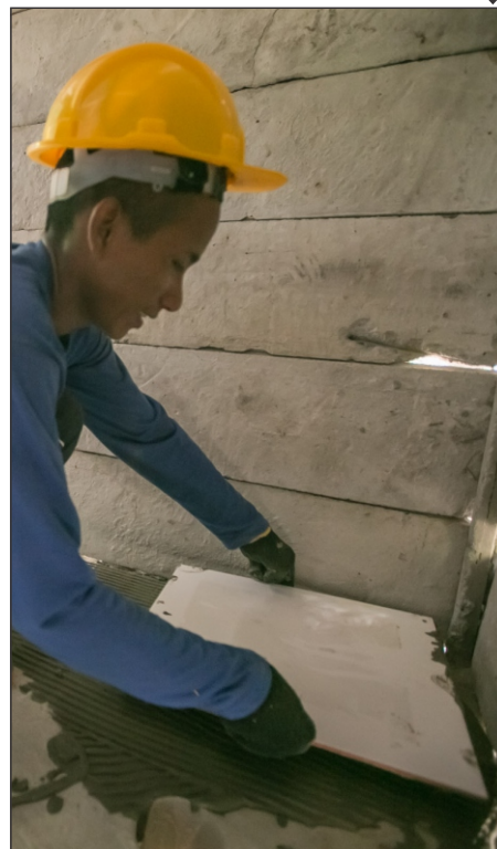
Assentamento do Piso Cerâmico. Fonte: Memorial Chico Mendes
