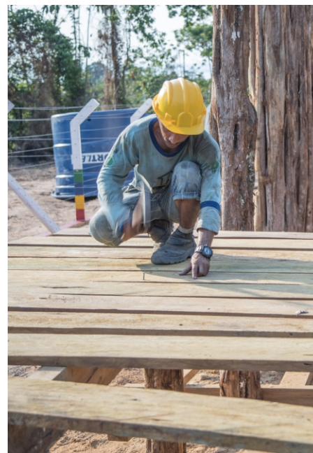
Construção do tablado de madeira. Fonte: Memorial Chico Mendes
