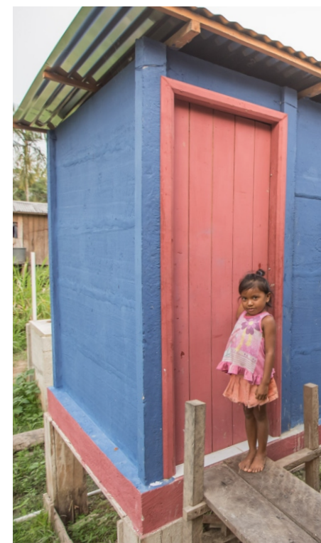
Banheiro em várzea concluído. Fonte: Memorial Chico Mendes
