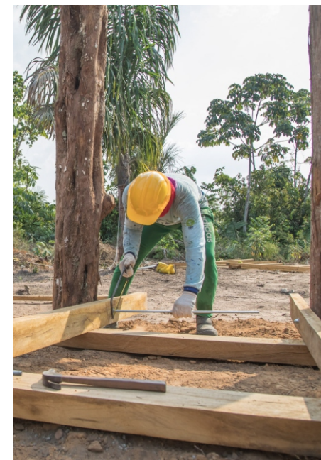
Travamento dos Pilares. Fonte: Memorial Chico Mendes
