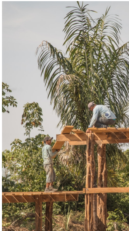
Construção da Base dos Reservatórios. Fonte: Memorial Chico Mendes
