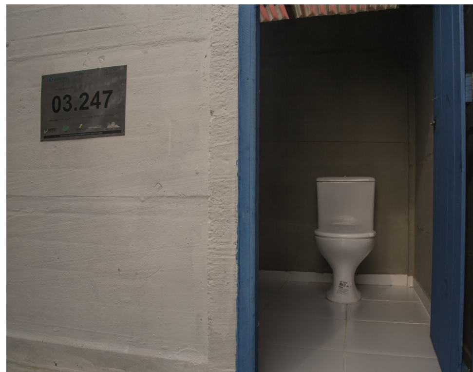
Banheiro construído. Fonte: Memorial Chico Mendes
