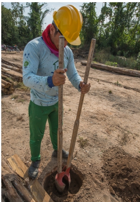
Escavação. Fonte: Memorial Chico Mendes
