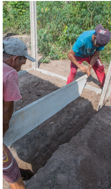
Escavação. Fonte: Memorial Chico Mendes
