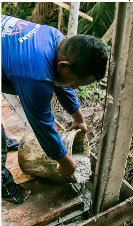
Concretagem do banheiro (em várzea). Fonte: Memorial Chico Mendes
