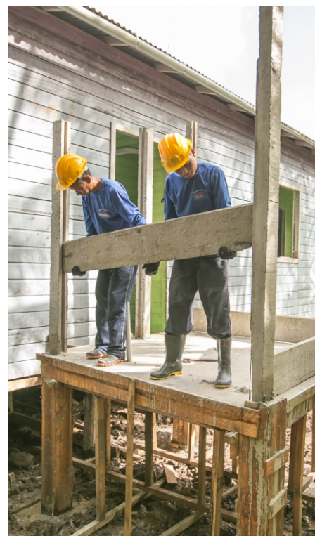
Encaixe de placas entre pilares de concreto. Fonte: Memorial Chico Mendes
