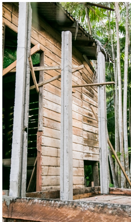
Cravação dos Pilares. Fonte: Memorial Chico Mendes
