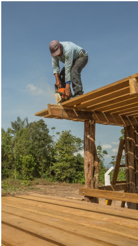
Construção da Base dos Reservatórios. Fonte: Memorial Chico Mendes
