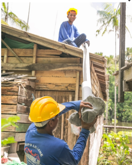
Colocação da Calha com Tubo de 100 mm. Fonte: Memorial Chico Mendes
