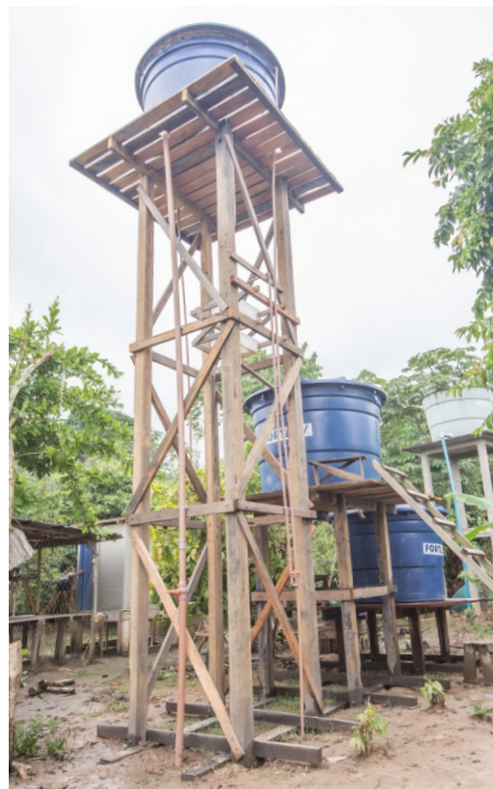
Disposição dos Reservatórios Elevados. Fonte: Memorial Chico Mendes
