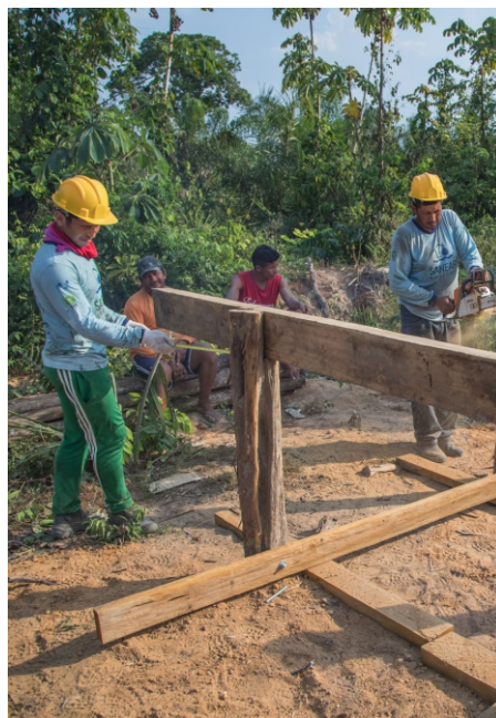
Cravação dos Pilares. Fonte: Memorial Chico Mendes
