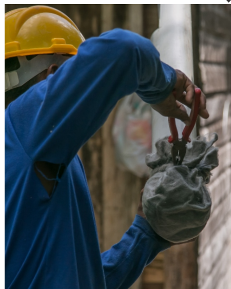
Colocação do tubo de 100 mm. Fonte: Memorial Chico Mendes
