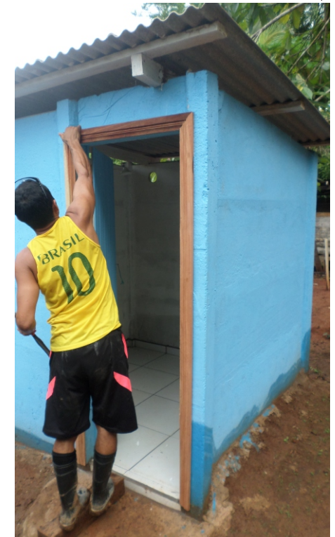
Banheiro construído. Fonte: Memorial Chico Mendes
